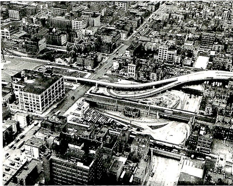
Fig. 2. Hovedmengden av trafikken kommer fra venstre fra Lincoln Tunnel Plazas. En parkeringsplass for busser er anordnet på det sted hvor oppkjøringsrampen begynner. Den trafikk som ikke kommer fra tunnelen kjører opp på den kurvete rampe som stikker under hovedrampen.
