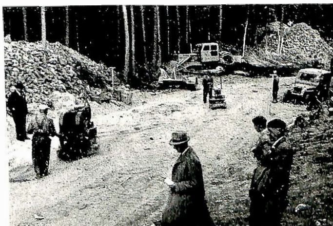
Fig. 15. Komprimering av vegfylling.
