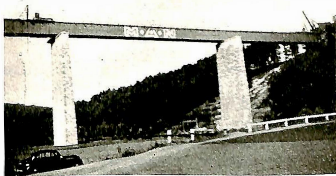
Fig. 6. Stålbjelkebru under oppførelse syd for Göttingen (autobanen).
