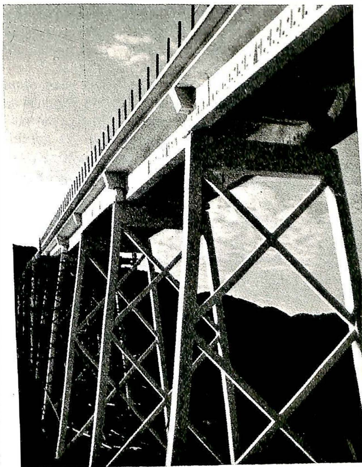
Fig. 8. Seksjon 1 (fastlandskarret — pilar VIII) ferdigstøpt.
