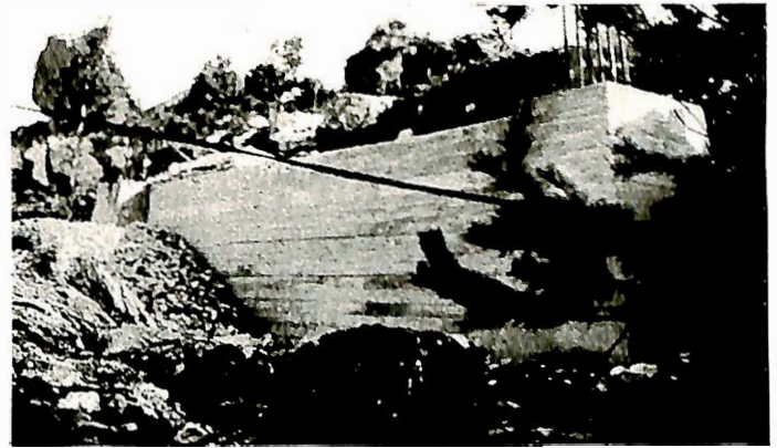
Fig. 3. Ett av landfundamentene.
