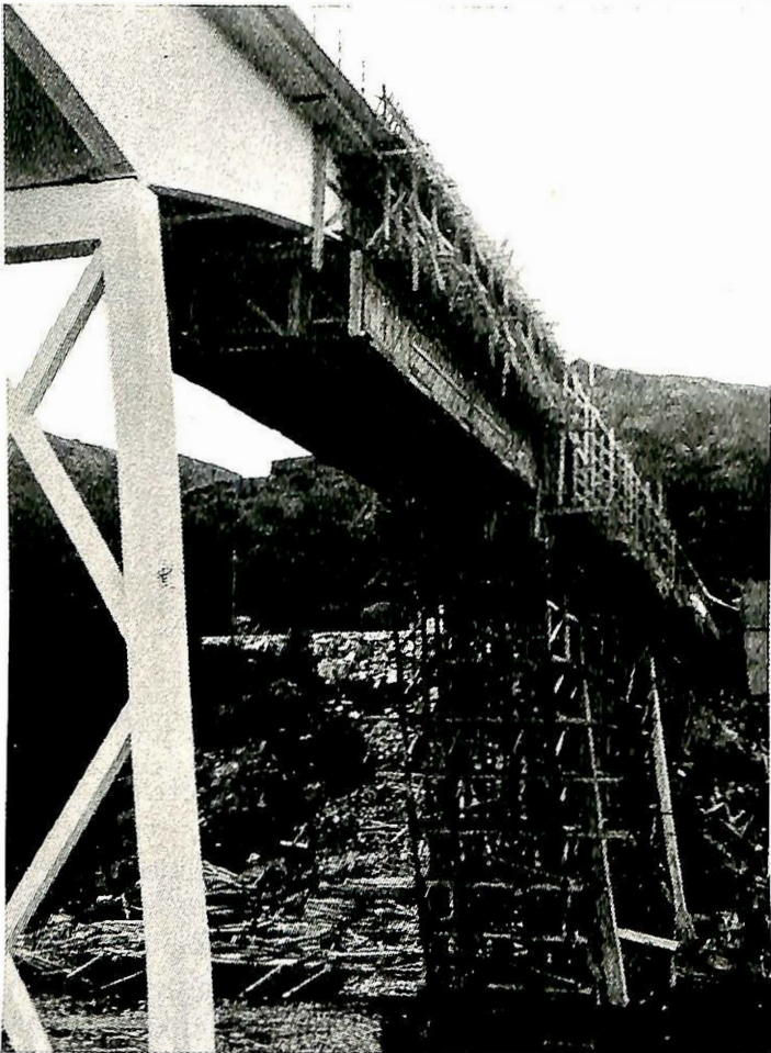
Fig. 11. Forskalling for det opphengte midtspenn i seilløpet på nært hold.
