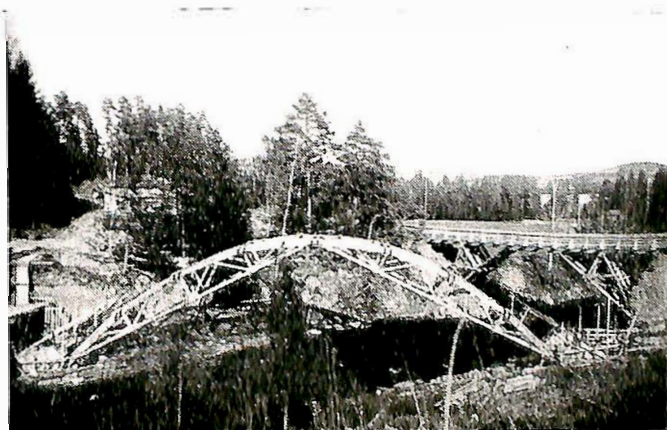
Fig. 5. Ferdig stillas ved Stokke.
