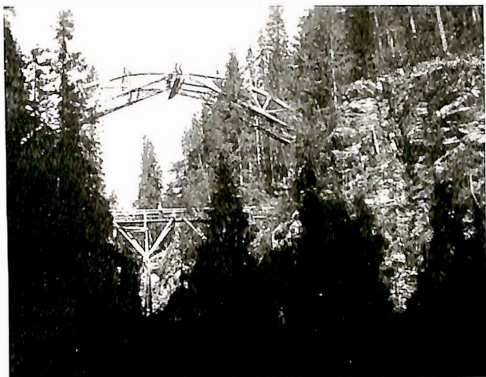
Fig. 3. Ferdig stillas ved Bråstad.
