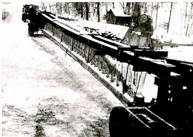
Fig. 6. 23 tonns betongbjelke på transportvogn.
