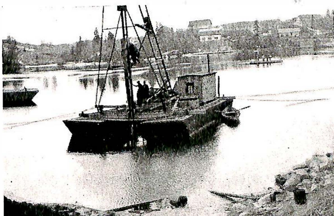
Fig. 1. Rambukk på to pongtongar av tre.
