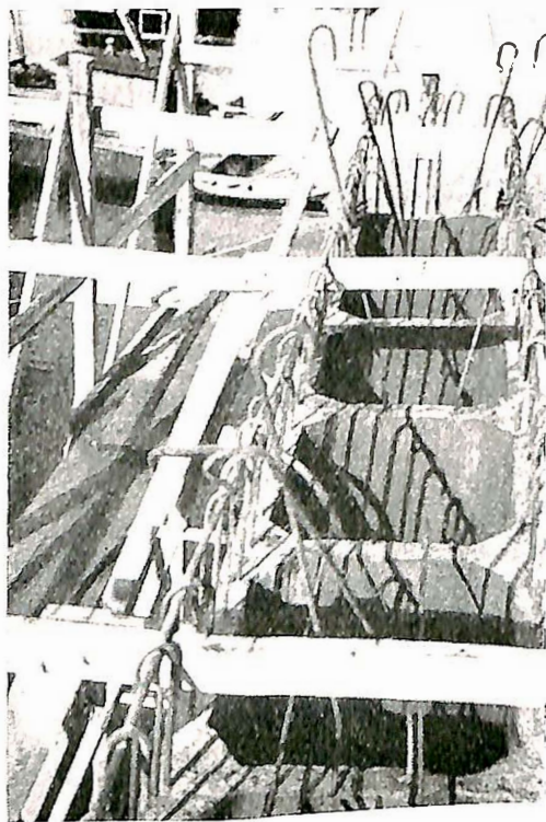
Fig. 4. Øvste enden av sunkasse av armert betong. Armeringsstøt stikk opp.
