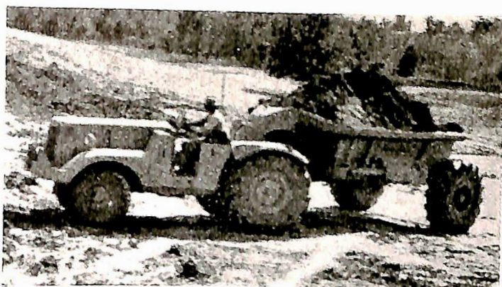
Fig. 34. Dumper (trailer) med bunntonning.
