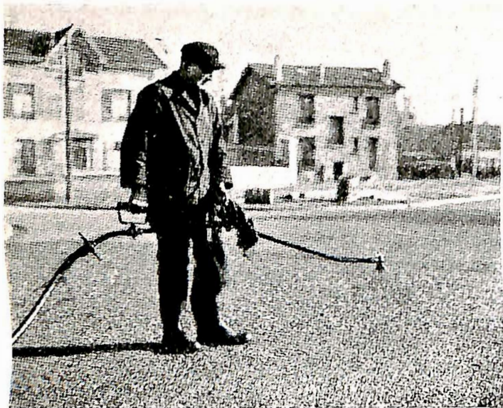
Fig. 11. Utførelse av Composol dekke.
