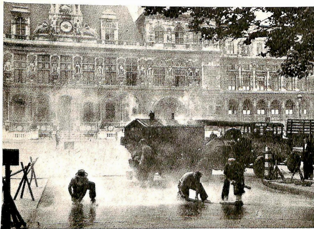
Fig. 4. Utlegging av «Asphalte coulé».
