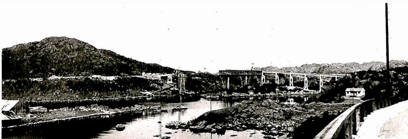
Fig. 1. Egerøy bru under bygging.
