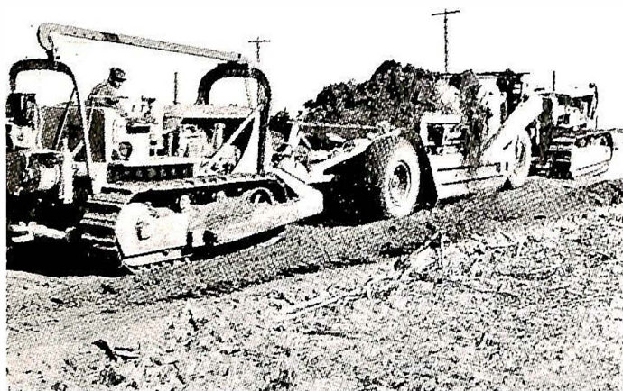
Fig. 27. Traktortrukken hjulskrape med «Pusher» i arbeid.
