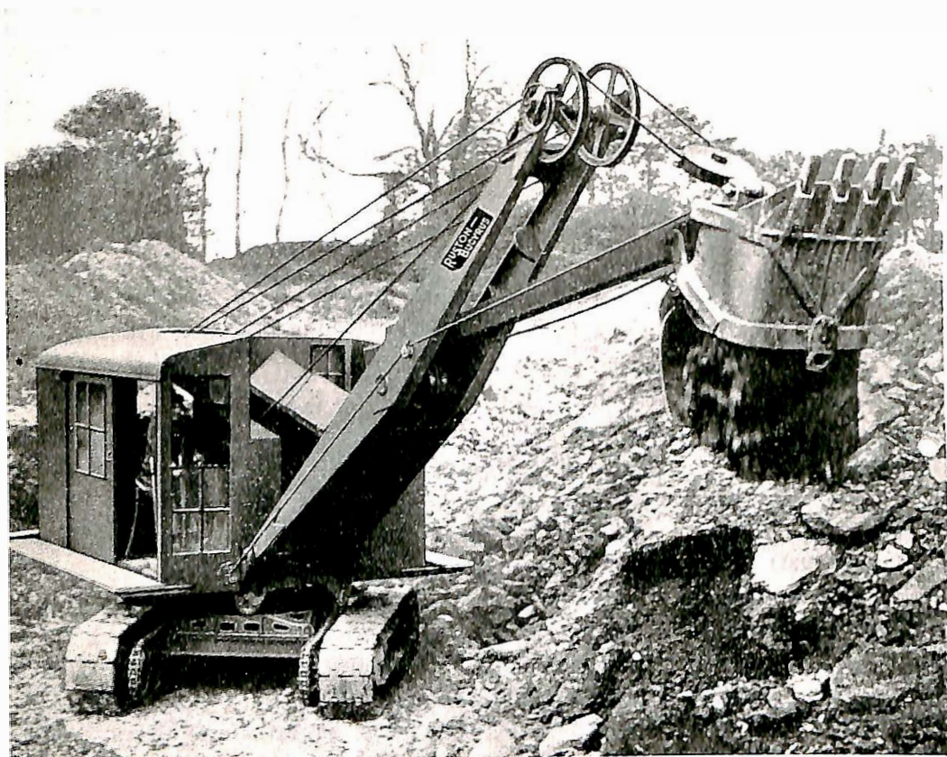
Fig. 1. Gravemaskin med forgraverutstyr.
