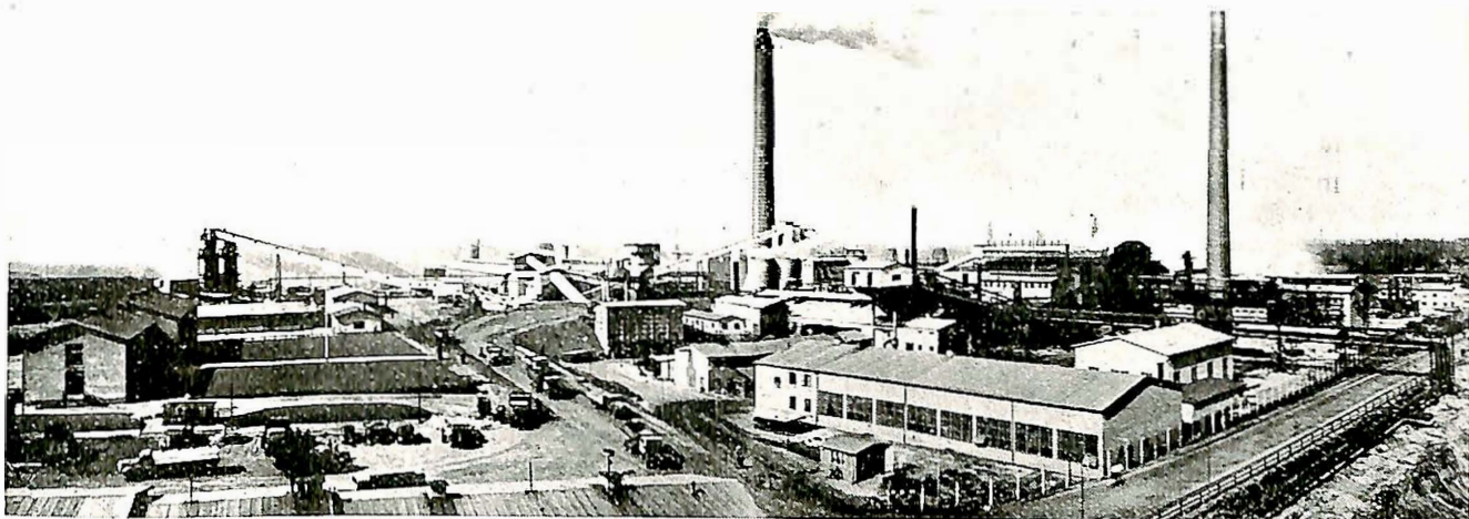
Fig. 8. Skiferoljeverket ved Kvarntorp.
