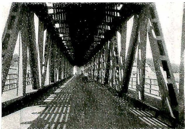
Fig. 3. Ei ny stålfagverksbrua med bilveg på nedre gurt og jarnbane på øvre gurt (oppå brua).
