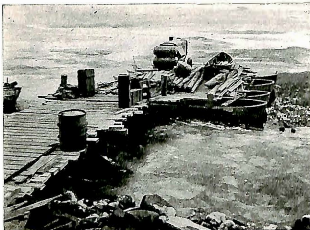
Fig. 7. Provisorisk ferje av gamle brupontongar og solid plankedekk.
