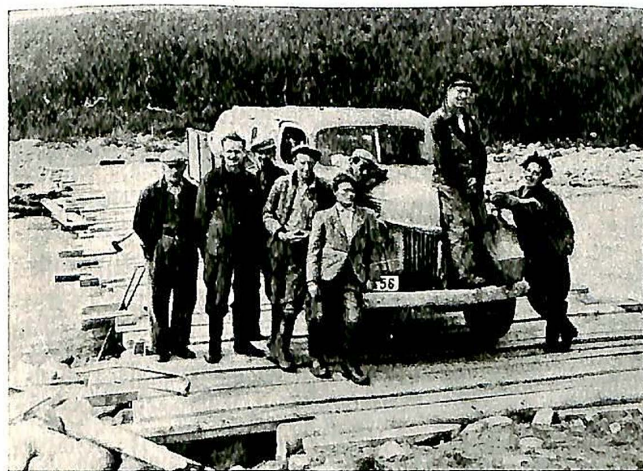
Fig. 5. Provisorisk bru over Storelv under bygging.
