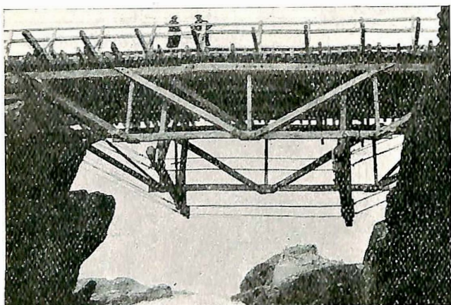
Fig. 9. Adamsfoss bru provisorisk gjenoppbygd.
