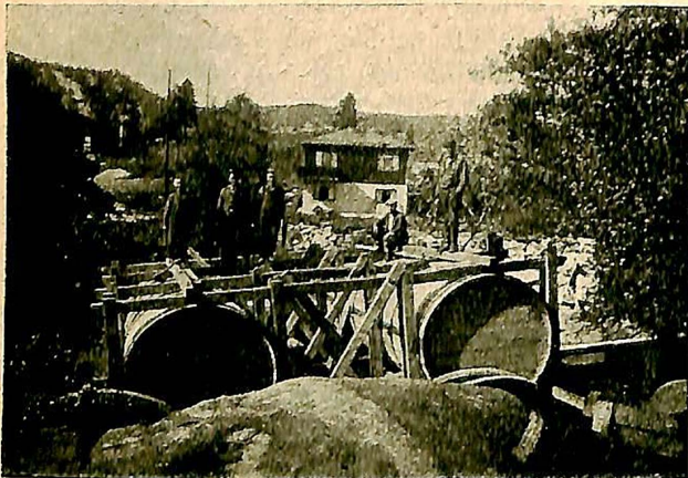
Fig. 2. Tvillingpontong ferdig til sjøsetting.
