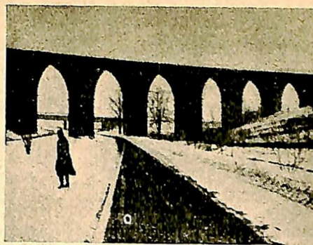
Fig. 2. Snøsporrense på riksbilvegen.
