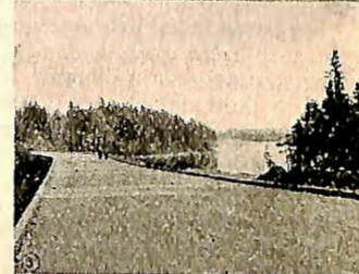
Fig. 2. Dobbeltsporet norsk riksveg med 6 m bredt betongdekk og godt rekkverk. Bemerk banketbredden.
