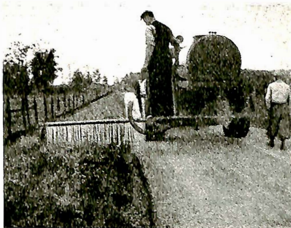
Fig. 2. Spreddeaggregat i arbeide.
