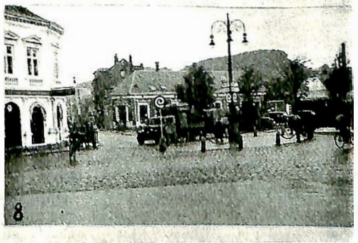
5. Særskilte kjørebener i kurve på svensk vei. 6. Rundkjøring i Randers — noe trang og uhensiktsmessig. 7. Nedkjøringen til Storstrømbroen. 2 kjørebener à 3,25 m. 2 sykkelstier à 1,5 m og 2 fortau à 0,75 m. 8. Rundkjøring i Vejle. Ordningen med at fotgjengere går på tvers over midtpartiet blir betegnet som uheldig.
