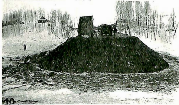
Fig. 8, 9 og 10 viser arbeidet ved planeringsfronten («endedumping»). Øverst til venstre: Fjernelse av vamsyke jordmasser med mudderskuffe samt traktor med «buldozer» i arbeide. Øverst til høire sees utgravde masser foran fronten. Nederst til høire: Ferdig vei over stabilisert myrstrekning.
