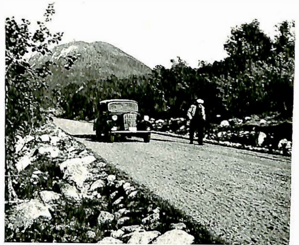
Vei nr. 795. Anletiget Strømmen—Sandvik. Undergrusen er lagt.
