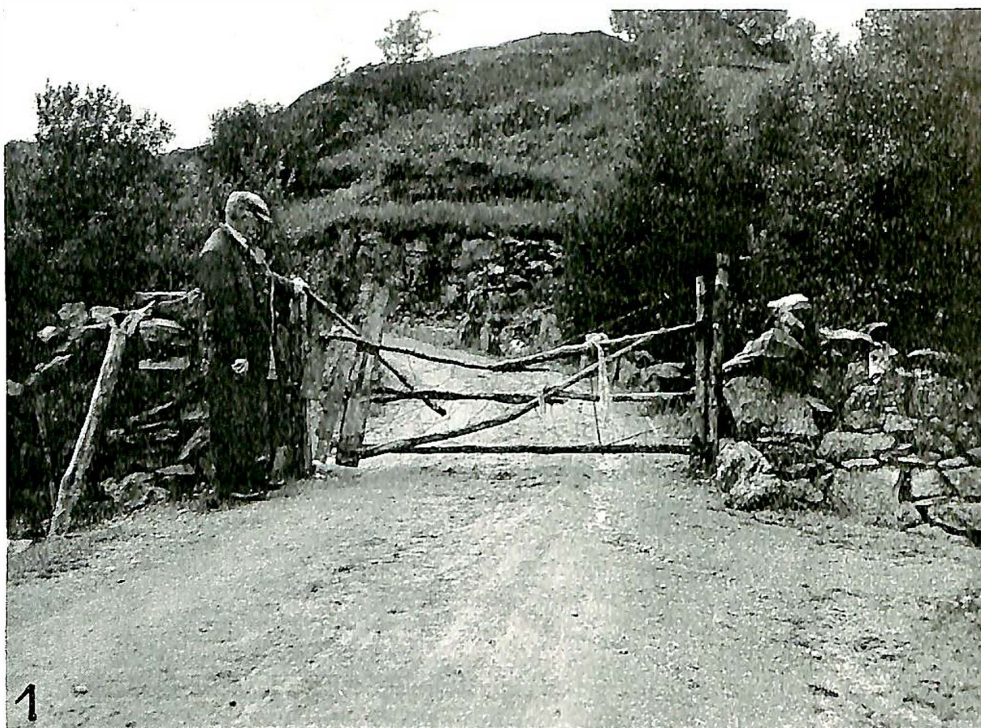
Fig. 1. Grind på riksvei nr. 541 på Radøy.
