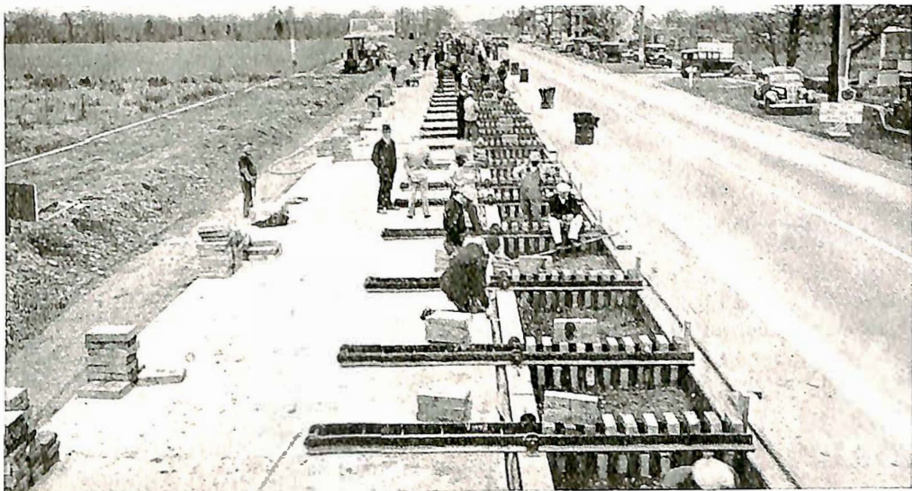
Billedet er tatt under forskyvningen av en stripe av betongdekket 455 fot lang, bestående av 13 deler à 14,5 x 35 fot. Det viser detaljer av apparatene, som letter oppblokkingen bak luftslangen etter hver forskyvning.
