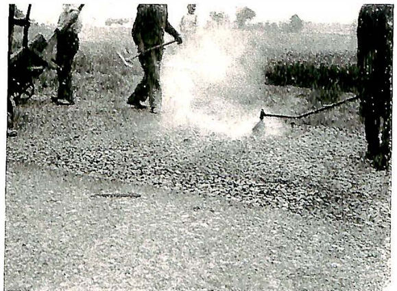
Fig. 4. Londals asfaltspreader (Nya asfaltbolaget, Kävinge).
