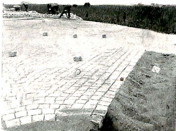
Fig. 3. Stensetning med smågatesten.
