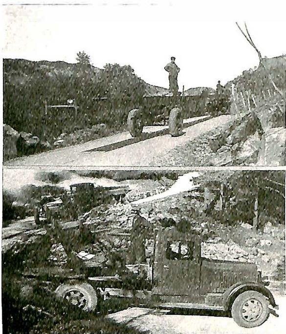
Transport av jernbjelker til veinlegget Valevatn-Kvina. Fot. Leif Hübner, Kr.sand.
