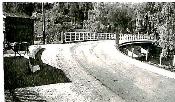
Ombygging av Tessa bru. Den provisoriske bru sees tilhoire på øverste billede. Nederst den nye bru.
