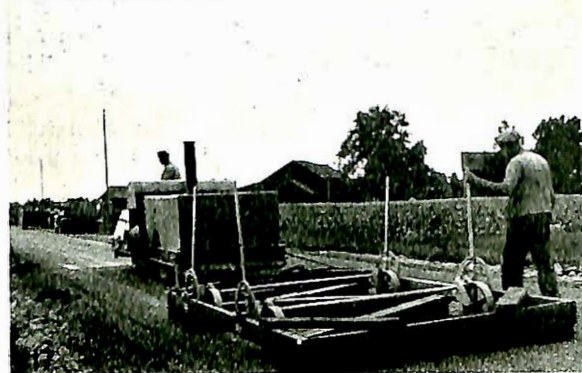
Fig. 15. Ferdig for grusspredning.
