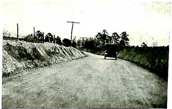
Fig. 4. Hårdt veidekke fremstillet av spesielle jordarter.
