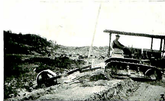
Fig. 1. Skrapen kjøres frem. " 2. Skrapen fulllastet. " 3. Traktoren snur.
