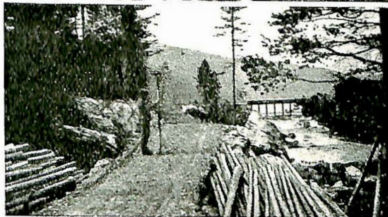
Øverst: Fra den nybyggede skogsvei Åmot—Fritsvann i Norderhov og Flå. Bemerk de slake grofter, som dog er store nok for overvannet.
