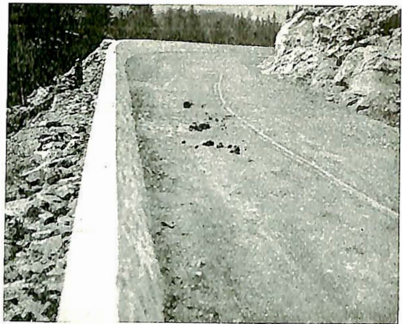
Utbedret kurve ved Høljerasten bro.
