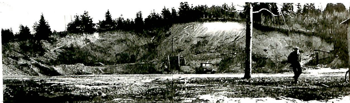
Eidanger grustak 20. november 1933, som man mener ikke tilfredsstillende kravene i fabrikktilsynets veiledning.
