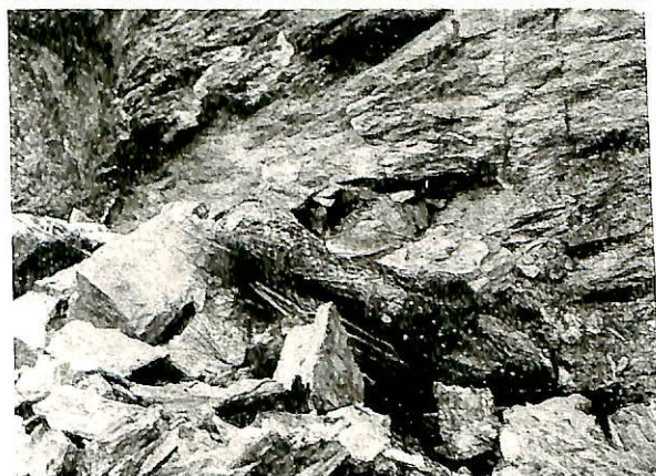
Blokksprengning: Dekning med faskiner og skytematter: Øverst: Før skuddet; Nederst: Skuddet er gått.
