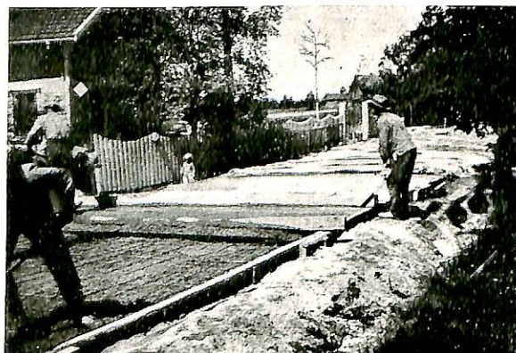
Øverst: Betongmassen tømmes. Nederst: Stampning. I forgrunnen sees jernnettet utlagt.
