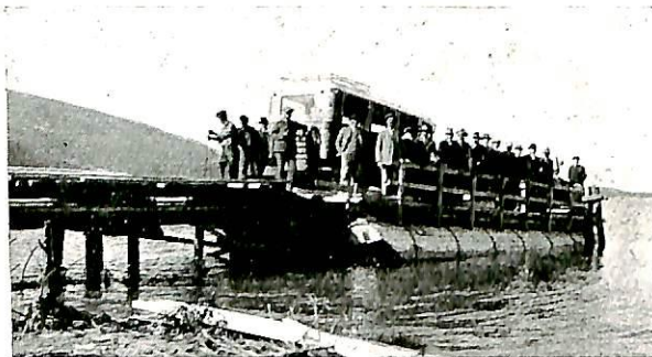
Den provisoriske ferje som blir brukt over bruddet i Høylandsveien i Nord-Trøndelag.
