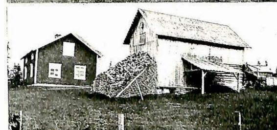
Veivokterboliger på Sandolaveien.
