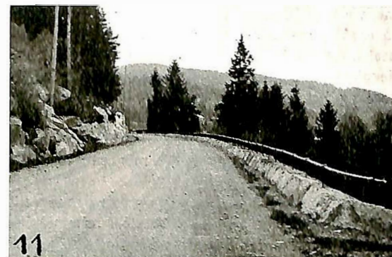
Fig. 9, 10, 11. Riksvei nr 50. Det gamle stabberekkverk omdannet til stenkant med skråning 2,5 : 1 med jernrekke på ca. 30 cm høie stolper.
