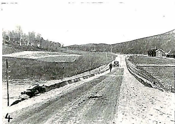
Fig. 4. Veien Tynset—Alvdal. 25 cm høi stenkant med skråning 2:1.
