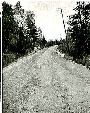
Pedrolittdekket lagt 1933. Uten 2 overflatebehandling Gustavsberg, Hemmesta.
