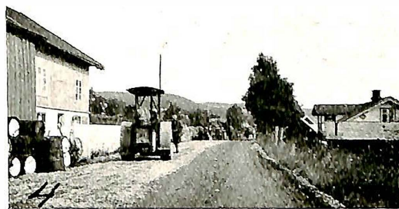
Nr. 1 og 2. Første behandling av veibanen med opletning av massen i ranke. Nr. 3. Annen behandling med spredning av ranken over igjen. Nr. 4. Valsning av pukklaget.
