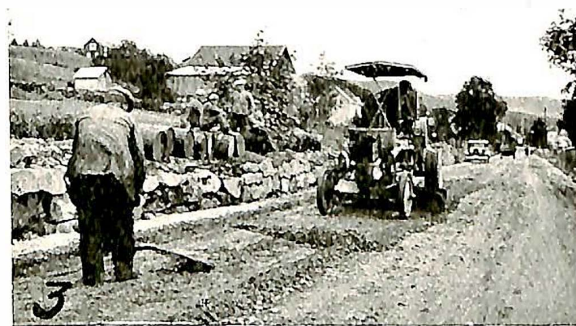
Nr. 1 og 2. Første behandling av veibanen med opletning av massen i ranke. Nr. 3. Annen behandling med spredning av ranken over igjen. Nr. 4. Valsning av pukklaget.
