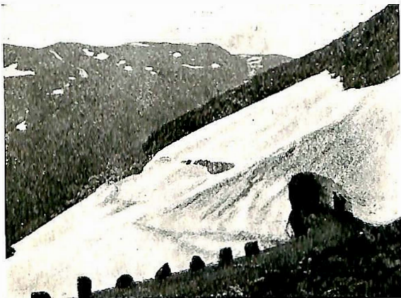
Snetunnel. Veien Årdal—Tyin.
