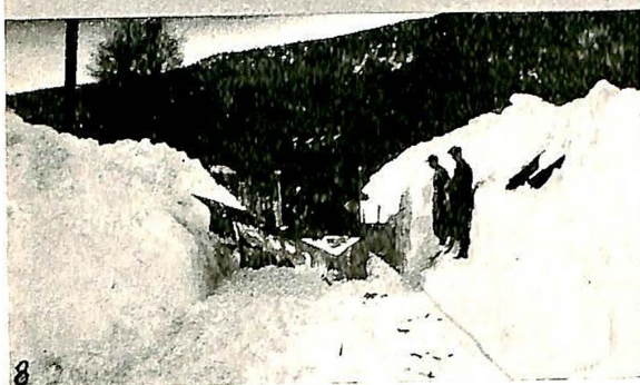
Fig. 6. Riksveien ved Komnes i Høland medio mars 1931. Fig. 7. Trondhjemsveien ved Grorud 26. mars 1931. Fig. 8. Trondhjemsveien ved Eidsvoll 26. mars 1931.
