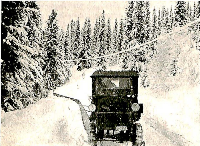
Fig. 9. Kant-rømning med sideplog.
