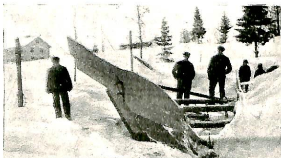
Billeder fra Snerthingdalen februar 1931. Gjerdene langs veiene er gjemt av sneen. Nederst en Teien-plog med påbygning.
