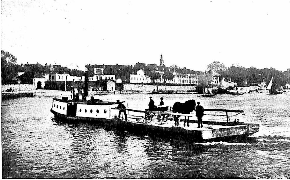
Fig. 1. Den gamle ferjeinnretning.
