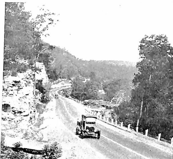
Landevei med markeringslinje i Tennessee, U. S. A.
