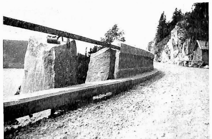
Fig. 14. Rekkverkstyper fjellterreng (Morskogveien i Akershus).
