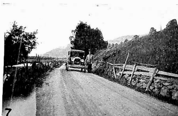
Fig. 6. Trondhjemsveien gjennom Gudbrandsdalen før høvling. Fig. 7. Samme veiparti efter høvling.
