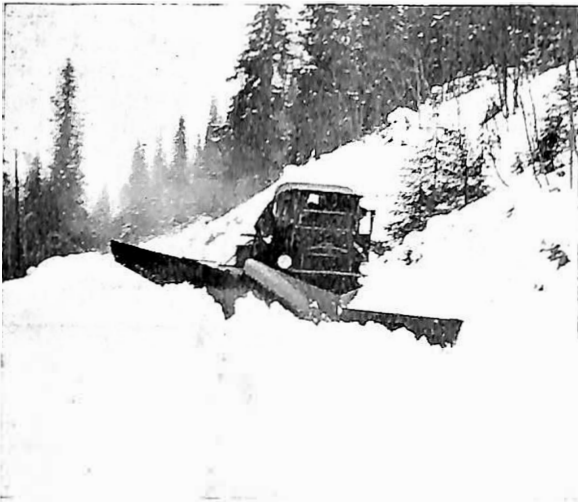
Selburutens nye plog i arbeide.
