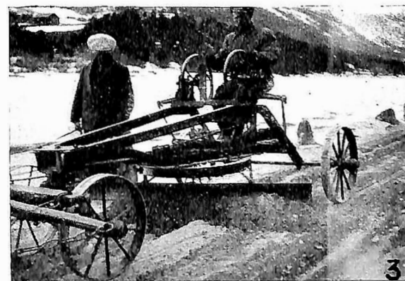
Fig. 1. Ottadalsveien før høvlingen. Fig. 2. og 3. Høvling av Ottadalsveien.
