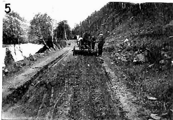
Fig. 4 Høveln montert med traktordrag. Fig. 5. Veibanen efter høvlingen.
