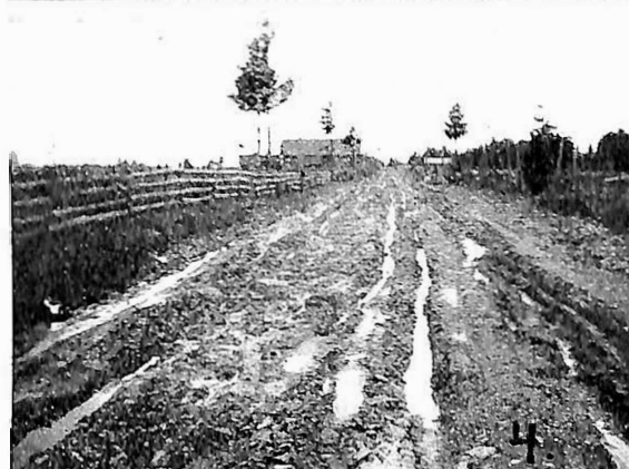
Fig. 2. Riksveien Kongsvinger—Oslo. Teleløsning april 1930 ved Sandbakken, 7 km vest for Kongsvinger. Granbar og teglstenskrot som nølforanstaltning.
