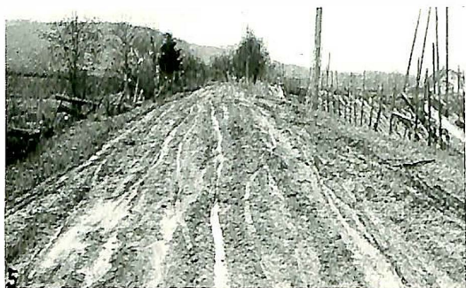
Fig. 5. Riksveien Kongsvinger—Oslo, straks vest for Kongsvinger. Teledløsning april 1930. Bemerk den forsmønte veigrøft t. v.
