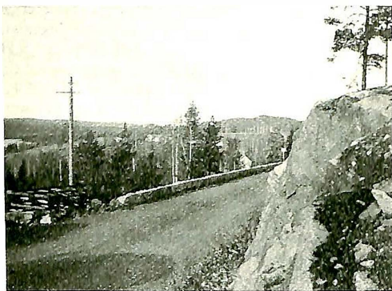
Fig. 5. Rekkverksmur, loddrett, 40 cm høi. Pris pr. 1. m kr. 5,50.
