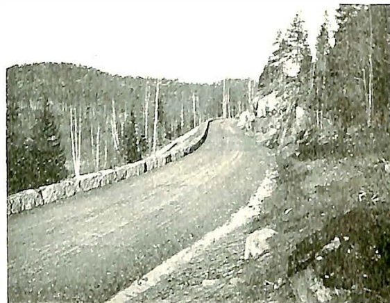
Fig. 4. Rekkverksmur, loddrett, 50 cm høi. Pris pr. 1. m kr. 6,00.
