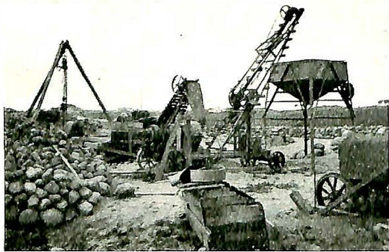
Fig. 1. Fintygger med forknuser. De to knusere med hver sin elevator er oppstillet i 90° vinkel med hinannen. (Knusning av kampesten til grus). Rogaland fylke.
