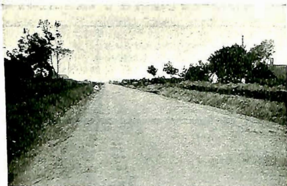
Fig. 2. Betongdekke på ny jordplanering.
