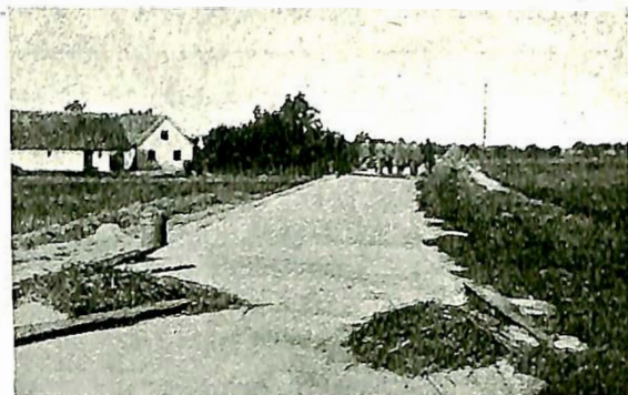
Fig. 3. Nylagt betongdekke, hvis ene halvpart er dekket av halm.
