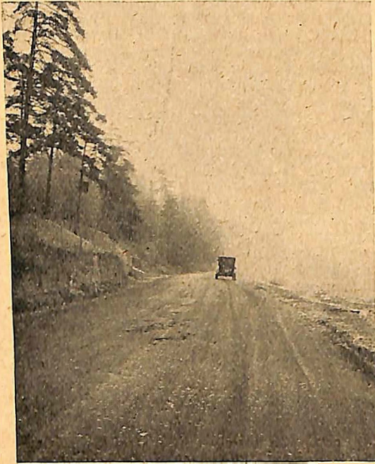
Fig. 5. Vei med flat grøft med noen drænering i bunden.
