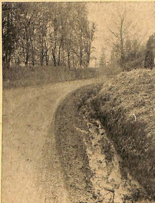
Fig. 6. Aapen grøft med hjulspor.
