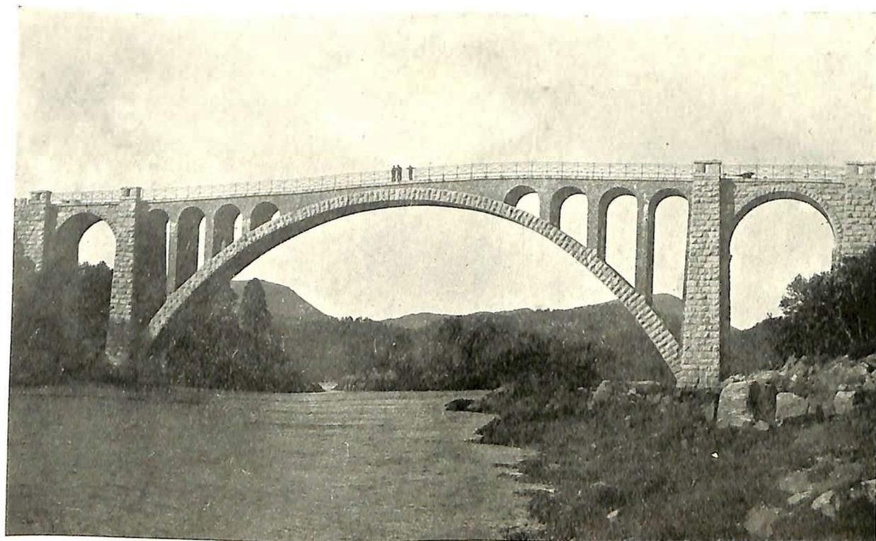
Fig 32. Skodjestrømmen bro. Møre fylke. Spændvidde 57,0 m. Kjørebredde 4,0 m.
