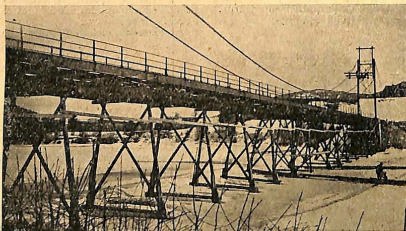
Fig. 6. Stillas med broen horisontalt utlagt.
