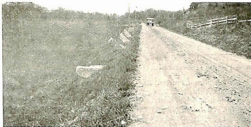
Fig. 5. Gammelt stabbrekkverk som nu er fjernet.
