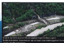
Et jord- og leirras over E6 ved oppkjøring til Høyvingen i Gudbrandsdalen. Vannet ser seg ras og legger store skred og store steiner i Gudbrandsdalen.
