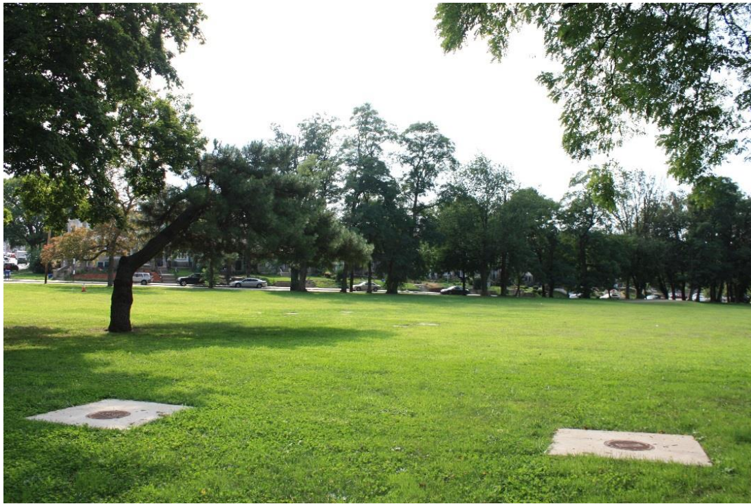
Under denne plenen er det anlagt store fordrøyningsmagasin.
