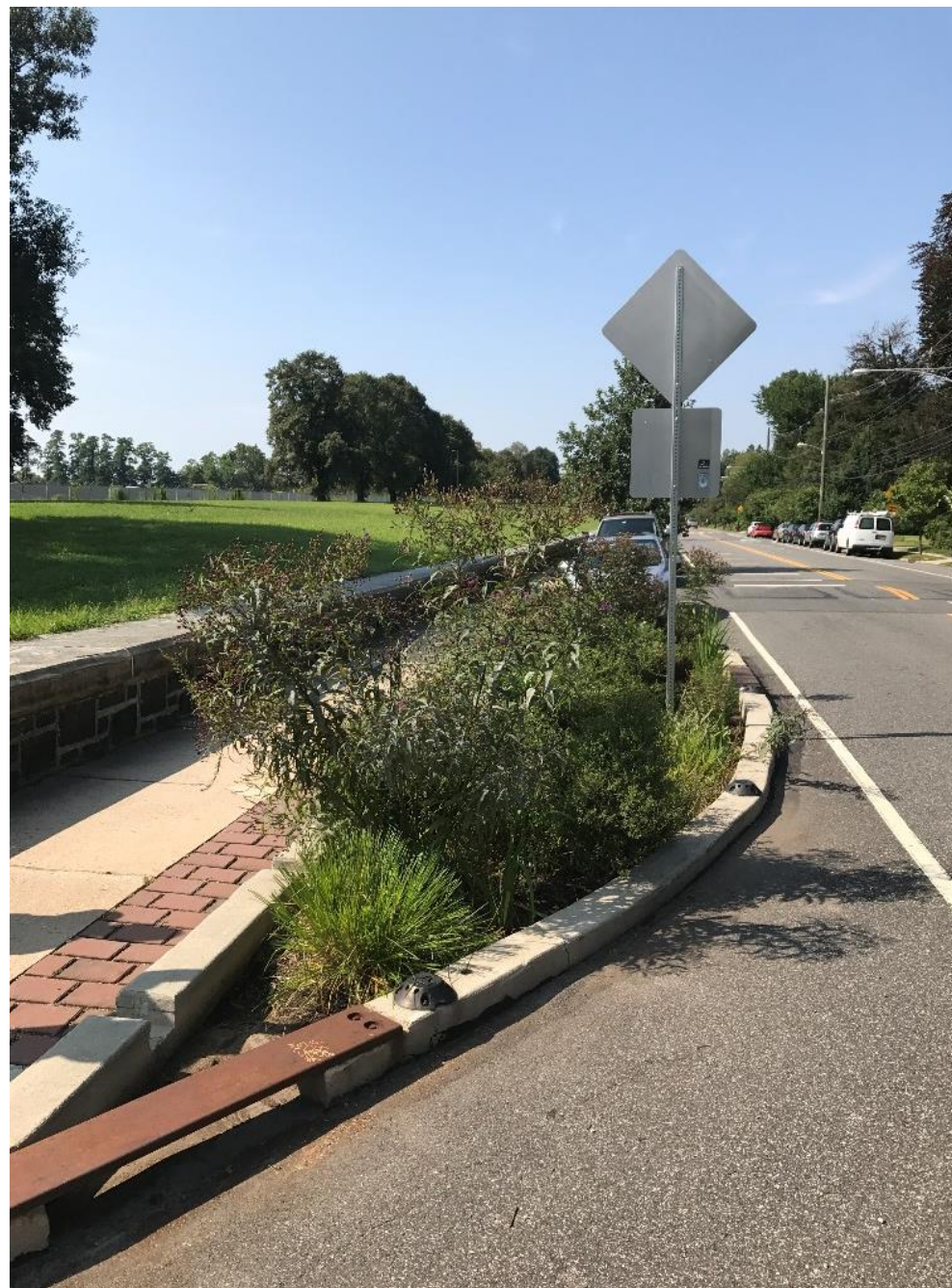
Bumpouts i Queen Lane. Legg merke til løsning av kantstein og åpning for vann fra gata.
