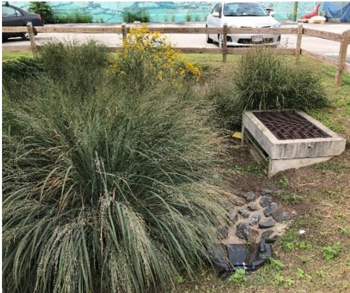
Vegvannet ledes ut i regnbed i sidearealene. Et gjerde hindrer søppel og tråkk i plantefeltene. Nederst til venstre sees overløpskum og vegetasjon i regnbedet.
