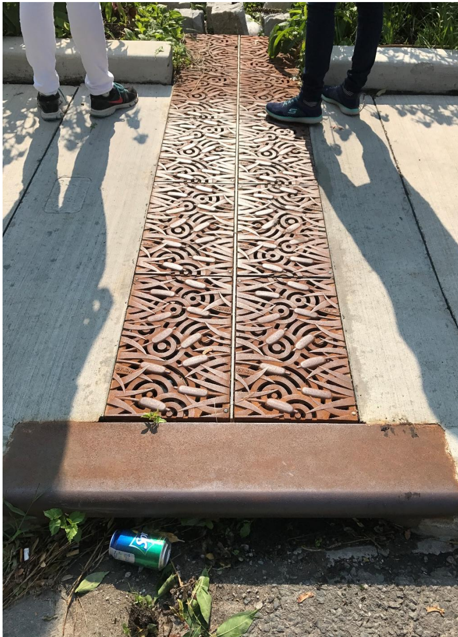
Spesialdesignede sluk og rister ved Fairford/Coxford Avenue framstår som små smykker i anlegget
