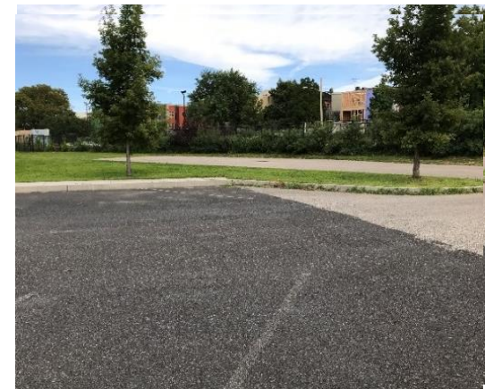
Permeabelt asfaltdekke på parkeringsarealet ved skolen.
