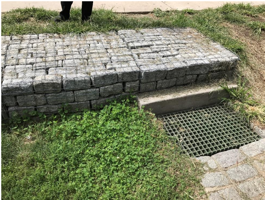
Gabionmur var brukt for å støtte opp og bremse vannet fra gata.
