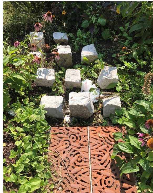
Det viste seg at det var behov for å bremse vannet ved utløpet for å unngå erosjon. Steiner er derfor lagt ut i etterkant.
