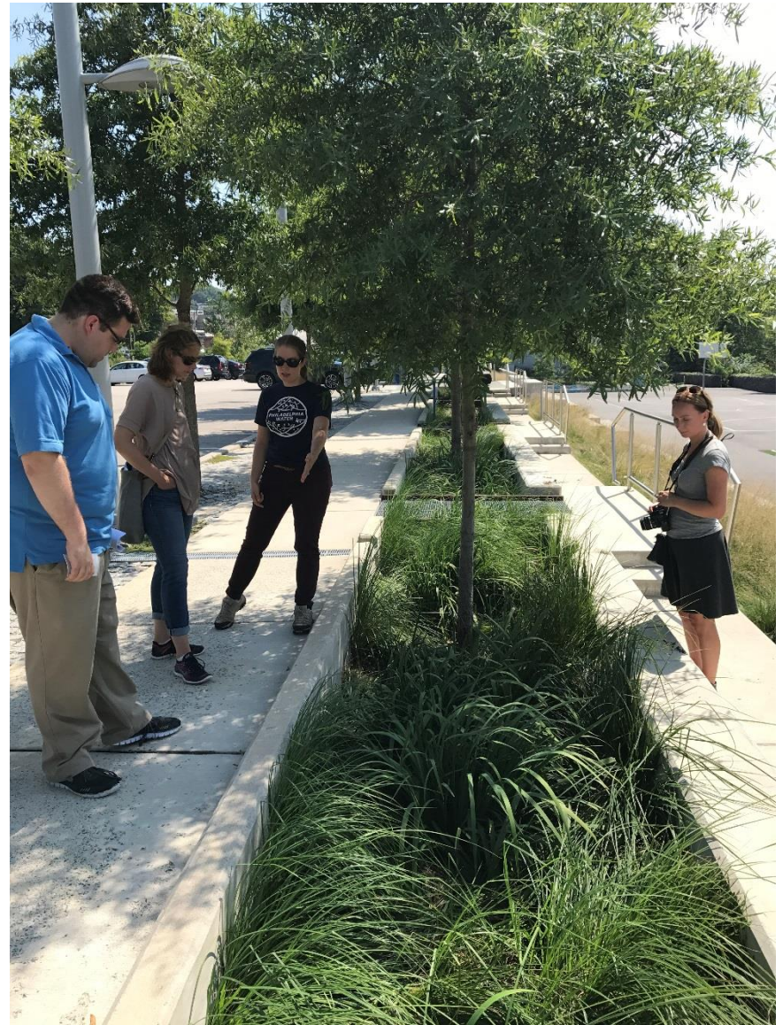
Regnbed samler opp vann fra overflaten av gangarealene og parkeringsplassen.
