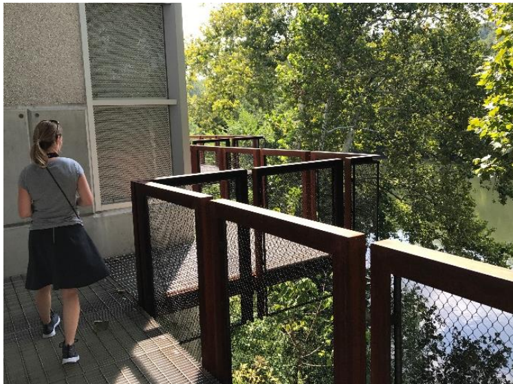
Rundt pumpestasjonen er det laget en gangvei med utsikt til elva.
