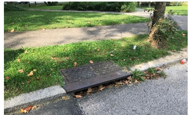
Stadebruk i anlegget over og til venstre. Bildene til høyre viser eksempler på sluk. Ristene må rengjøres hyppig.
